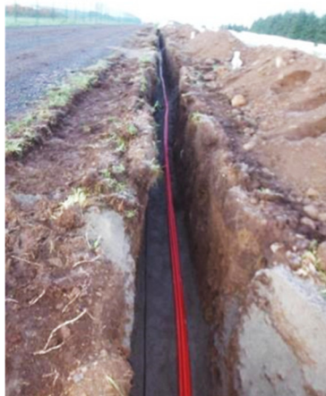
FOTOGRAFÍA 3 - Ejemplo de zanja para la instalación de cables eléctricos.
